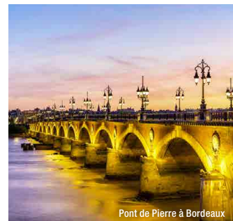
Pont de Pierre à Bordeaux
